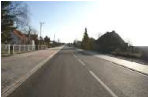
Wyremontowany odcinek drogi 2417P Lusowo – Dąbrówka
