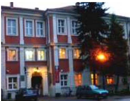
Budynek SOSWDN w Owińskach po termomodernizacji
