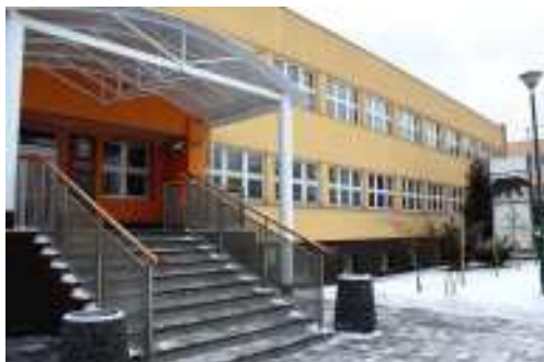
Budynek ZS w Bolechowie po termomodernizacji
